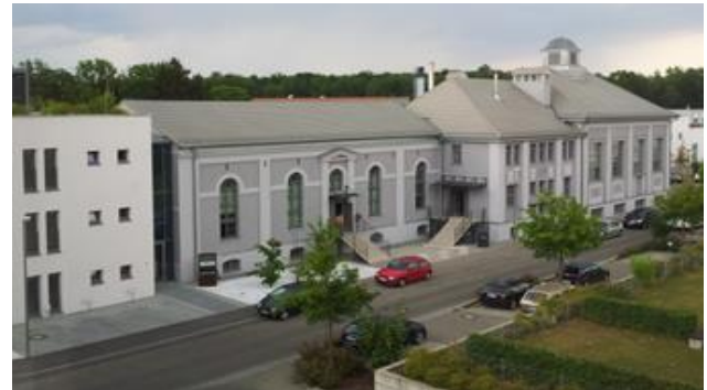
Abb. 2: Ein erhaltenswertes Maschinenhaus wurde hier beispielgebend über einen Glasbau mit einem modernen Gebäude verbunden. (Foto LfU)
