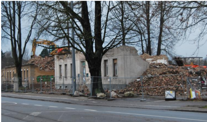
Abb. 3: Abbruch eines Gebäudekomplexes mit lokalgeschichtlicher Bedeutung 2011.
