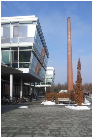
Abb. 1: LfU-Gebäude mit Schornstein als Kunst am Bau (Foto LfU)
