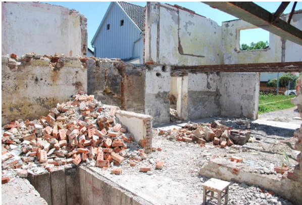
Abb. 3: Dieses Gebäude war einem Brand zum Opfer gefallen. Wir bauten es zurück, nachdem alle Brandschutt-Bestandteile entfernt waren (s. Abb. 4). Ein Großteil der Ziegel lässt sich wiederverwenden. (Foto Pacello)
