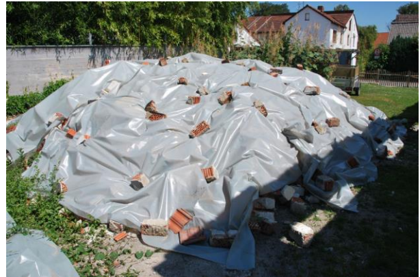
Abb. 4: Der Brandschutt liegt vor Regen geschützt noch unter einer Plane und wartet auf die fachgerechte Beseitigung. (Foto Pacello)
