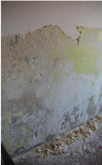
Abb. 5: Um an die Ziegel oder den Beton zu kommen, müssen Putz und Tapeten entfernt werden. (Foto Pacello)
