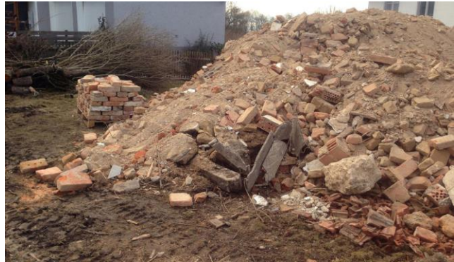
Abb. 6: Manuelle Trennung noch brauchbarer Ziegel aus dem Bauschutt und eine Palettierung derselben; eine Säuberung der Ziegel ist nicht notwendig. (Foto Pacello)
