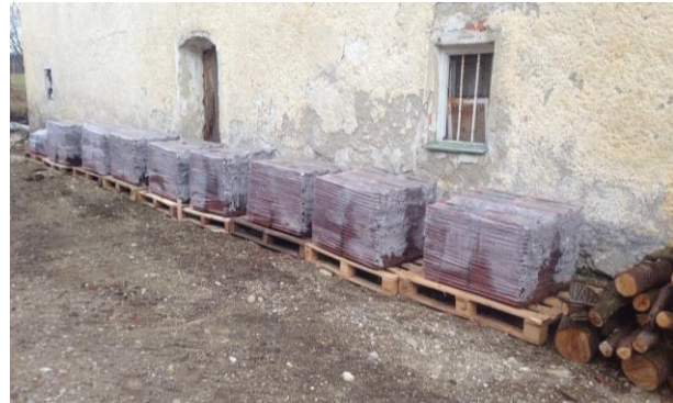
Abb. 8: Zwischengelagerte, auch in großer Menge generierbare, wieder verwendbare Dachziegel (Foto Pacello)
