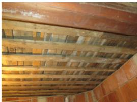
Statt der üblichen Fehlbodenkonstruktion bei Holzdecken wurden die Balken „Mann bei Mann“ verlegt, die Holzdecken bestehen somit aus massiven Balken.
