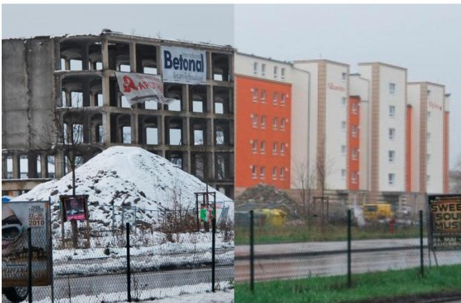
Abb. 2: Auch wenn das alte Gebäude nur teilweise erhalten bleibt, lässt sich nachhaltig Bauschutt vermeiden: Um die bewahrte Stahlskelettstruktur eines Kasernenbaus herum (Bild links) entstand ein modernes Heim für betreutes Wohnen. (Bild rechts). (Fotos LfU)
