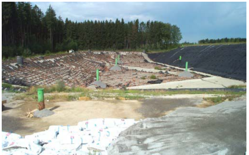
Abb. 7: Arbeitstägliche Abdeckung von asbesthaltigen Abfällen
