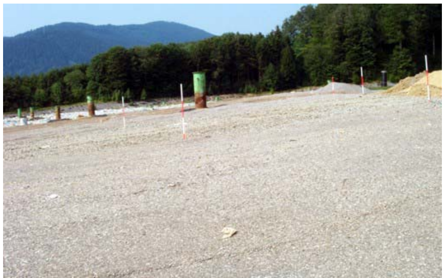
Abb. 8: Ausgleichsschicht aus MV-Asche
