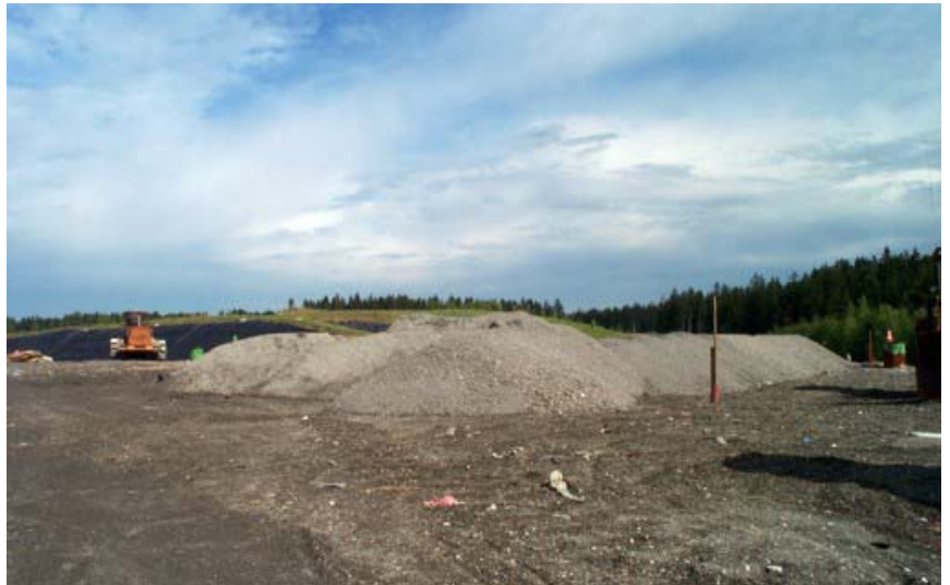
Abb. 6: Damm zur Abtrennung verschiedener Deponiebereiche
