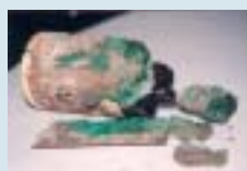
Bohrkern eines Hallenbodens mit grünen Chromverunreinigungen
